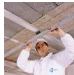
Prostopadle do już zamocowanych profili CD przytwierdzamy (na zatrask) profile poprzeczne.
