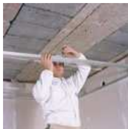
Po zamocowaniu profili UD na obwodzie pomieszczenia umieszczamy wieszaki i montujemy profile podłużne CD.
